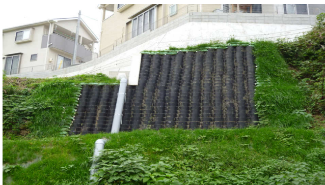
上温品 石原田団地内法面改修工事
