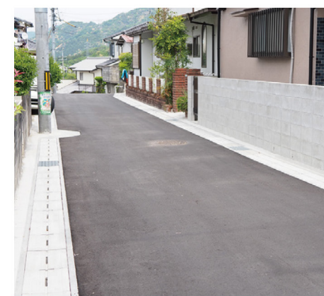
馬木9丁目側溝ふたかけ工事
