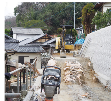
上温品1丁目里道災害復旧工事
