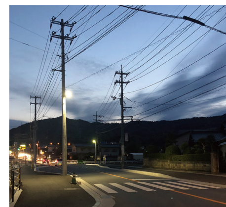
東インターハイツ入口 街路灯設置
