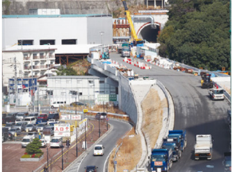
広島高速5号線二葉山トンネル広島駅北口入口
