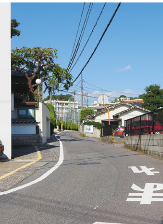
温品公民館前交差点～温品小学校正門付近までの道路拡幅工事
