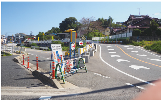
馬木工区(天王橋)
