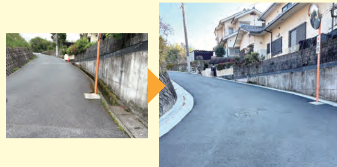
【側溝に蓋かけをすることにより、歩行者も車両も安全に通行できるようになりました】
